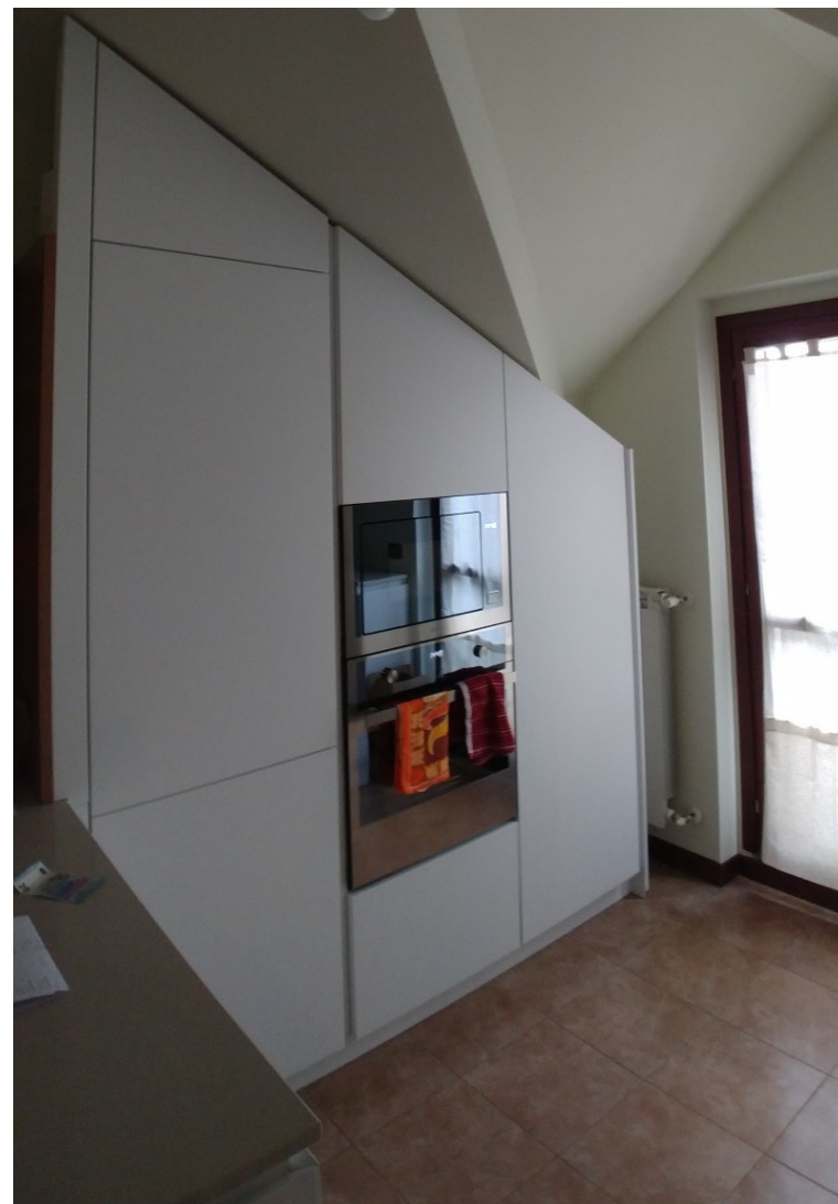
. Realizzazione parete colonne cucina
